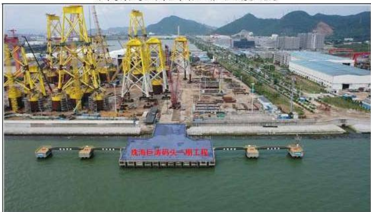
图 3.1-2 珠海巨涛码头一期工程
